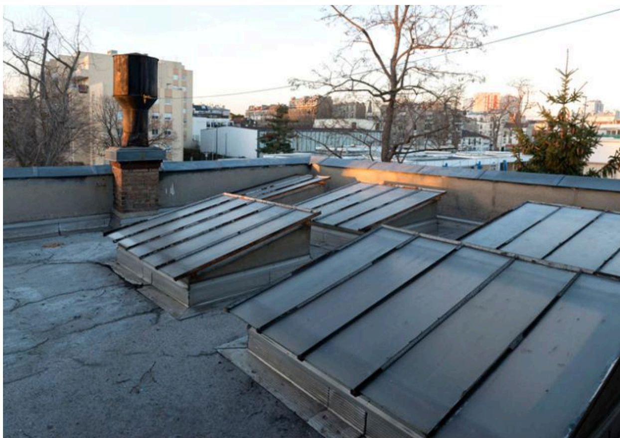
Détail du toit-terrasse de l'établissement et des lanternaux éclairant le couloir distribuant les cabines.
