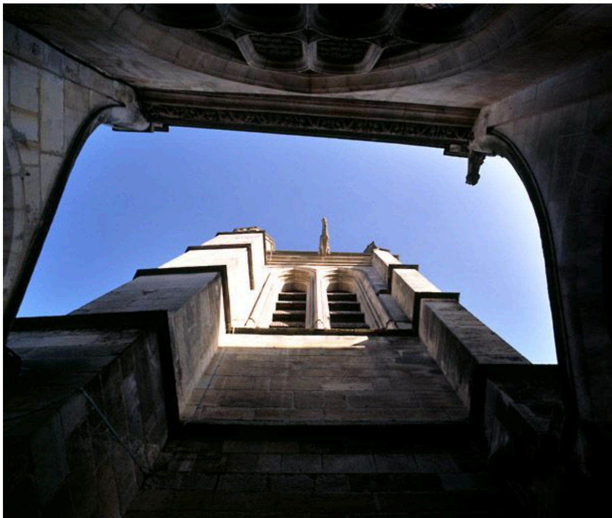
Face sud du clocher, vue depuis la terrasse du collatéral nord.
