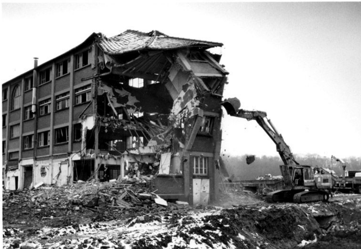
L'usine en cours de démolition. 20 décembre 1997. (Collection particulière)
