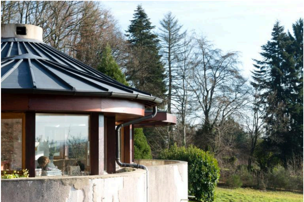
Détail d'une des excroissances située à l'extrémité droite de la maison.
