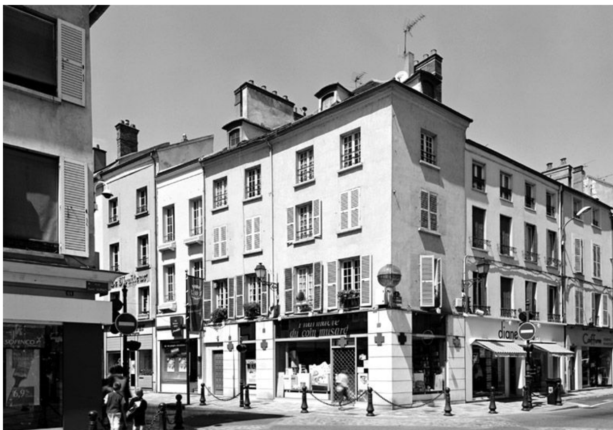
Vue d'ensemble des immeubles à l'angle de la rue Carnot et de la rue du général de Gaulle, abritant des vestiges Renaissance de l'ancien hôtel-Dieu Saint-Jacques.
