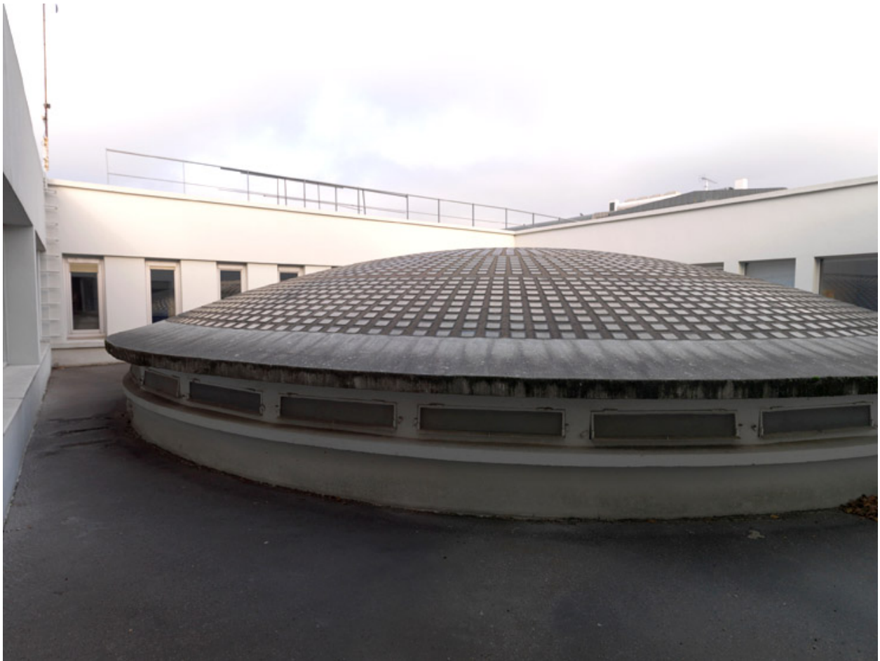
L'extrados de la coupole et son environnement.
