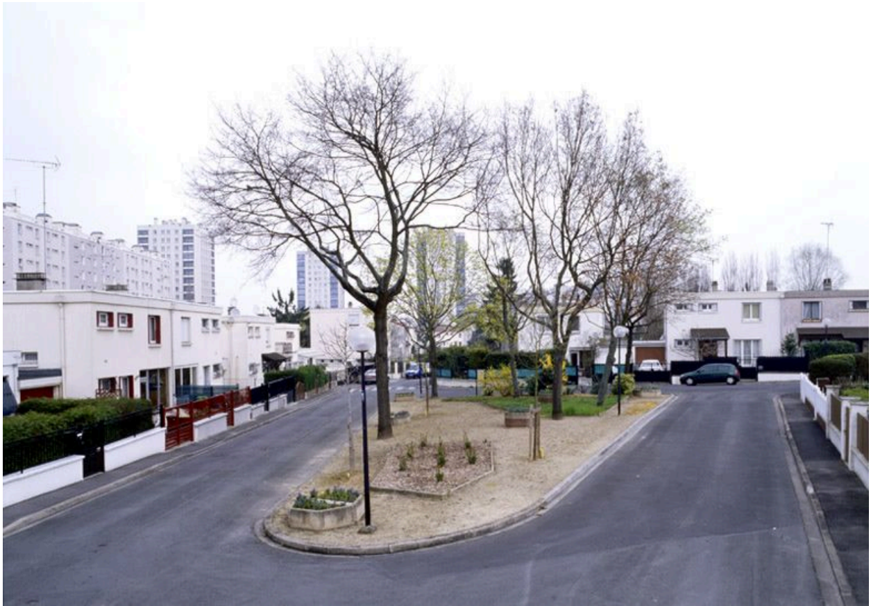
Lotissement concerté dit Champigny Résidences, villa Molière. Vue d'ensemble des maisons, logements sociaux en accession à la propriété construites en 1967.
