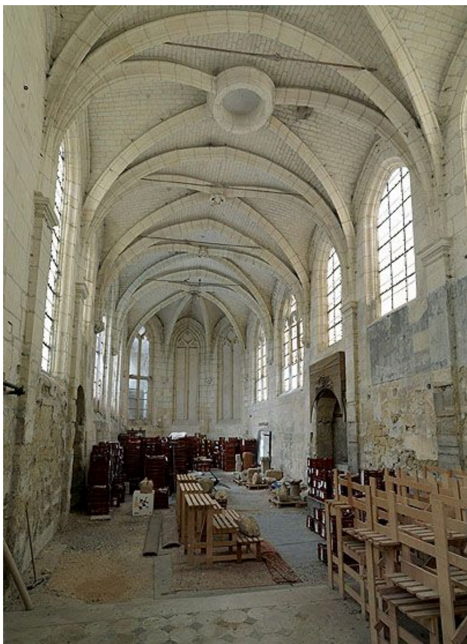
Vue intérieure générale, depuis l'ouest.
