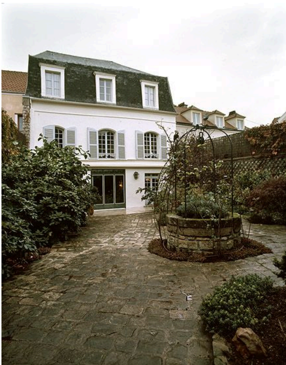
Vue de la façade sur jardin.
