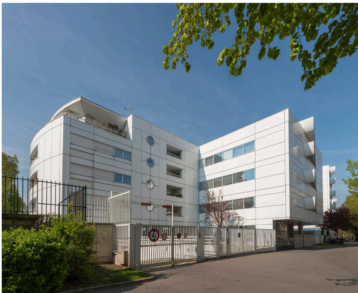
Vue latérale du lycée. Au dernier niveau, à l'angle, les logements.
