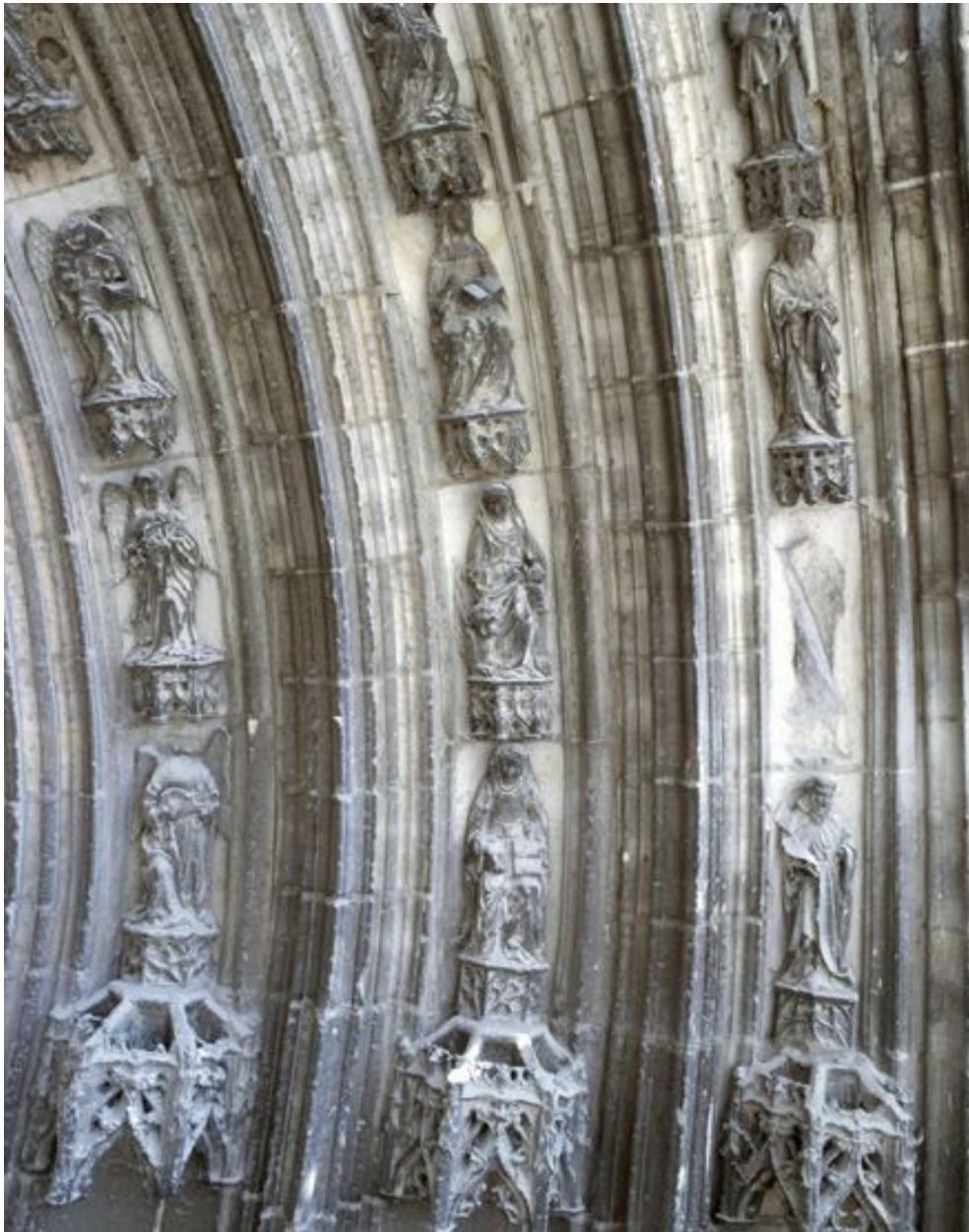
Les sculptures du portail Saint-Jean-Baptiste, vues depuis l'échafaudage dressé pour la restauration de la base de la tour nord (2008) : les voussures, à droite du tympan.
