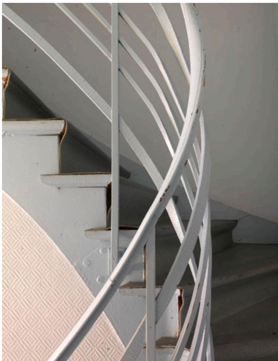
L'escalier conduisant aux logements.
