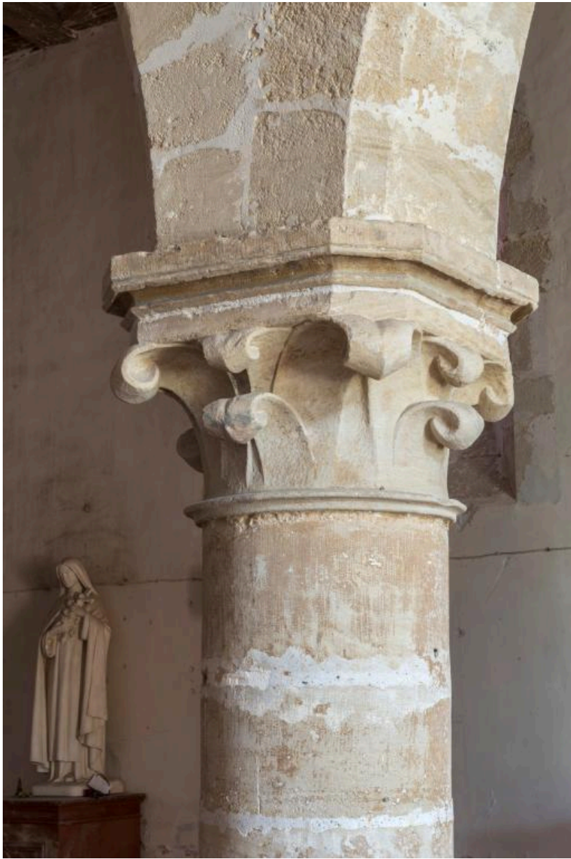
Chapiteau sculpté de motifs végétaux de la troisième colonne des grandes arcades (XIII e siècle).
