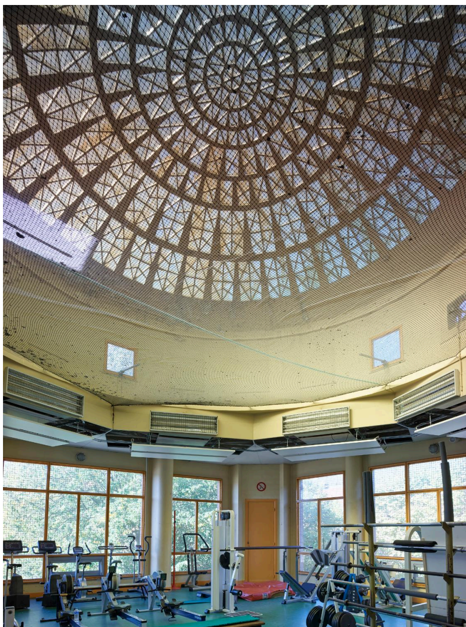
Détail d'une coupole en pavés de verre, éclairant zénithalement un gymnase.
