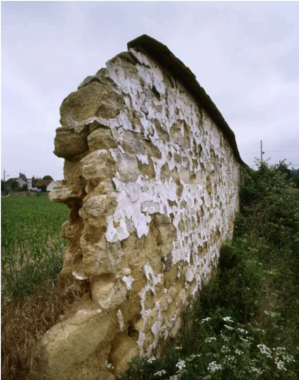
Maurecourt. Anciens murs à chasselas rue de Pontoise : composition du mur.
