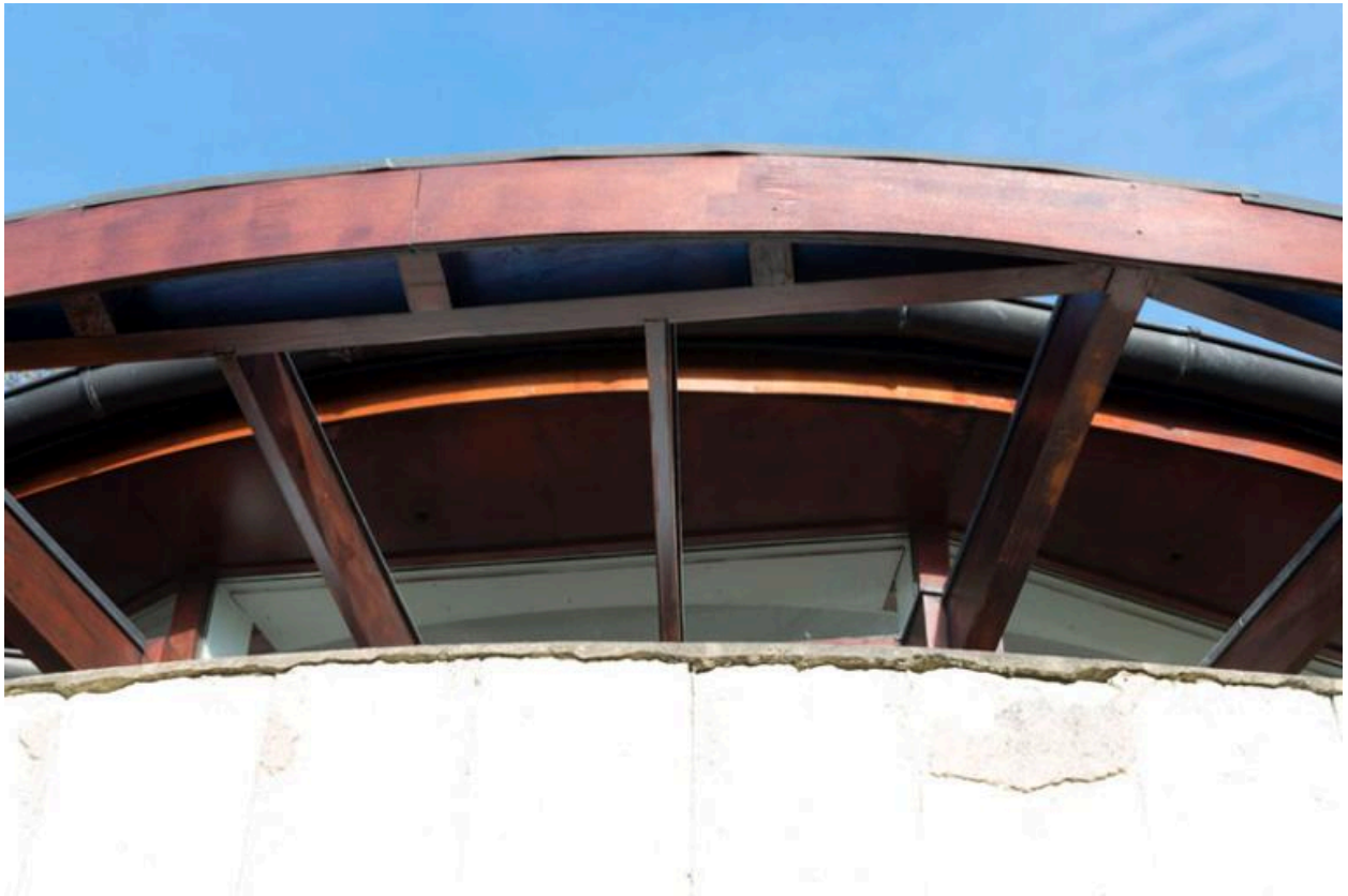
Détail d'une fenêtre (élément central de la façade).
