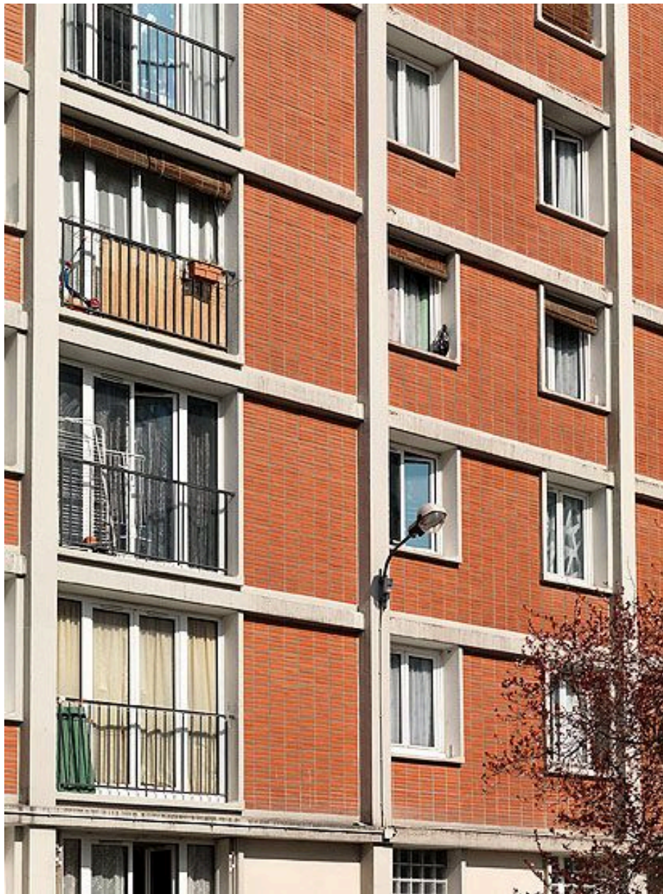
94, Ivry-sur-Seine, immeuble dit Cité Gagarine, allée Gagarine. Détail de la façade à structure de béton et remplissage de panneaux préfabriqués de briques.
