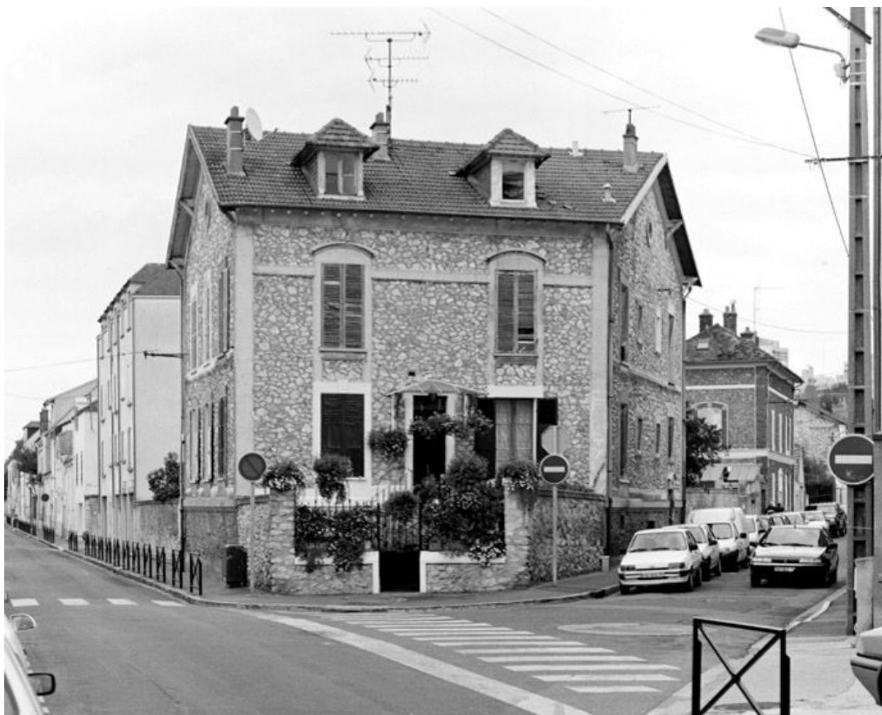
Maison à l'angle de la rue Crévoulin (n°1) et de la rue Camille-Flammarion (n°12), construite en pierres apparentes entourées de joints rocaillés.
