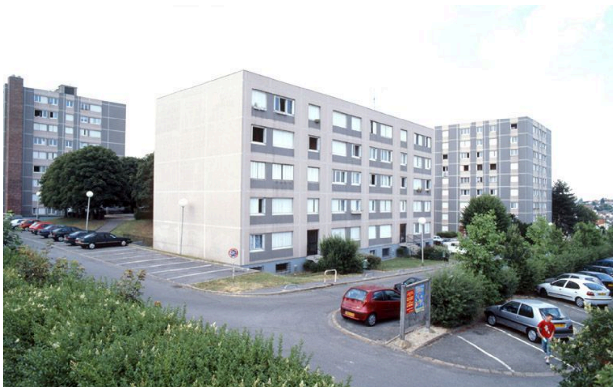
Cité des Perroquets, rue des Perroquets. Vue de deux des bâtiments de la cité, aujourd'hui copropriété.
