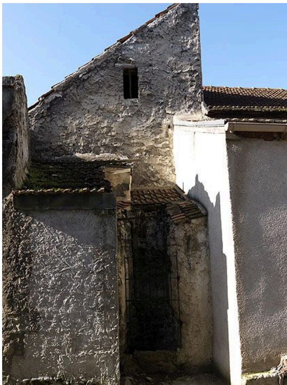
Bâtiment au 109N, avec le renforcement abritant le puits commun.
