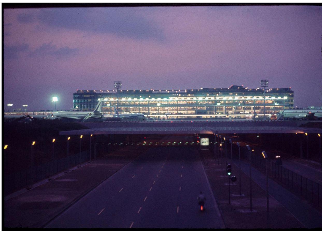
1961 1966, les Installations Terminale vues depuis le sud.
