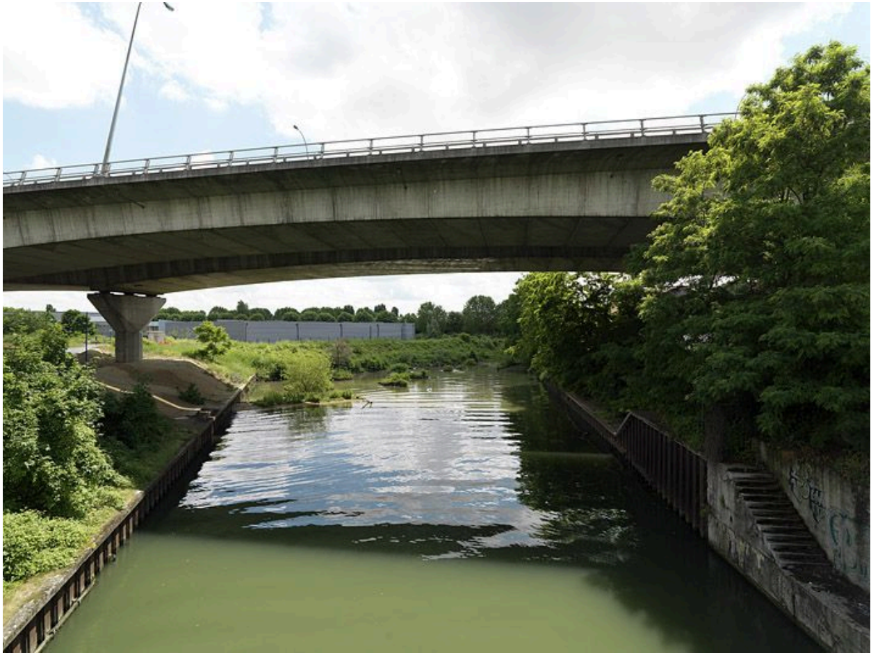
Choisy-le-Roi, Alfortville, Vitry-sur-Seine. Pont de Choisy de l'A86. Vue rapprochée du viaduc enjambant la darse d'Alfortville.
