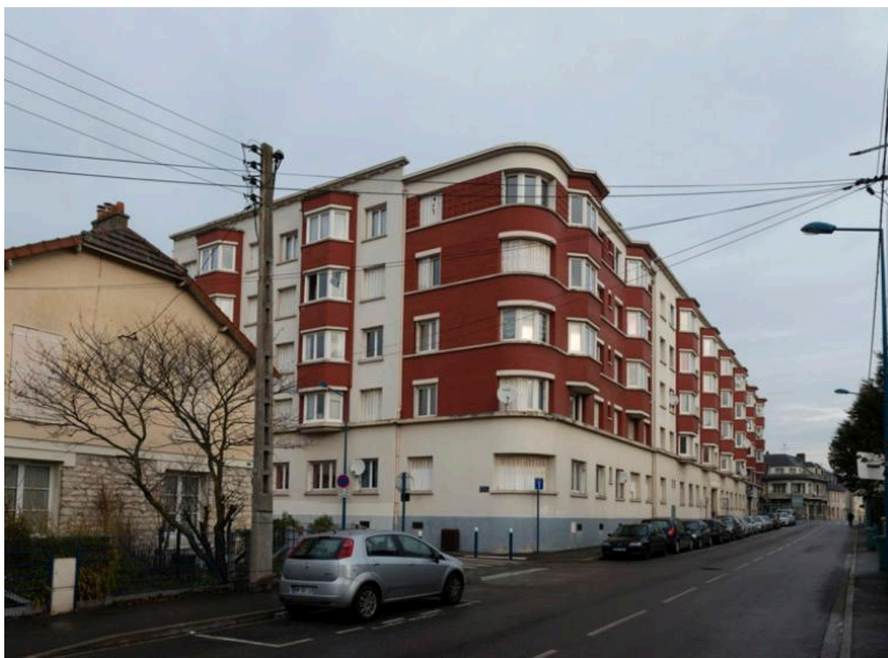
Vue de l'immeuble sur la rue Emile-Zola.
