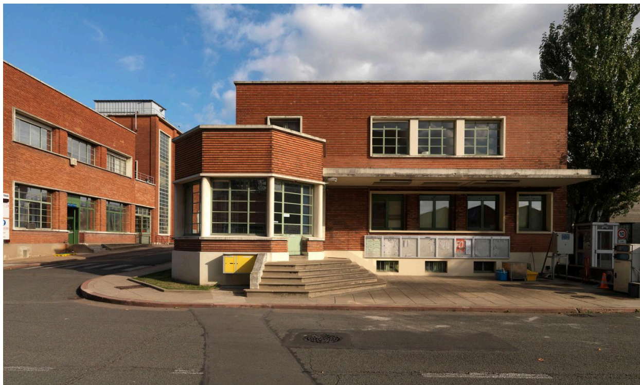
Site Sanofi, vue de l'accueil et du bâtiment administratif.
