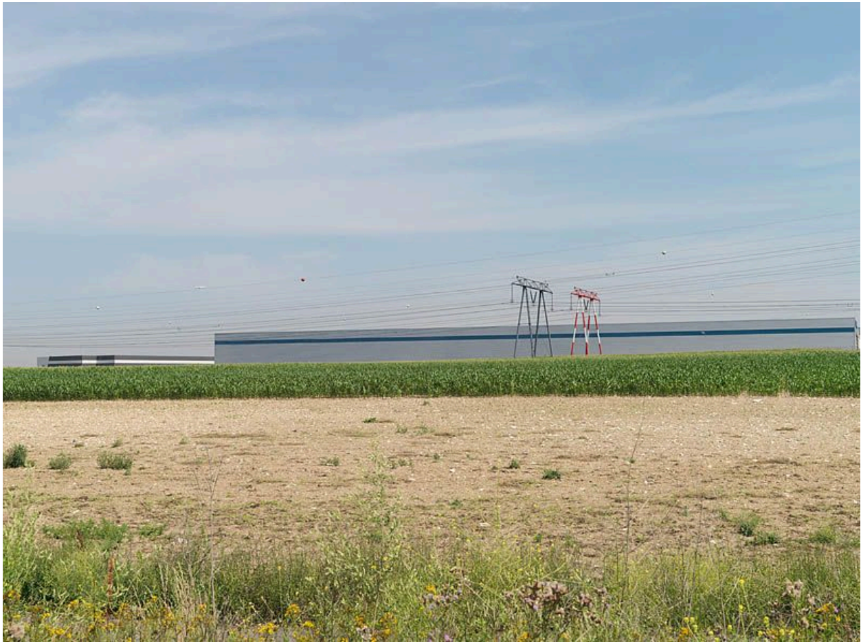
95, Le Thillay. Vue générale sur les entrepôts derrière un champ de maïs.
