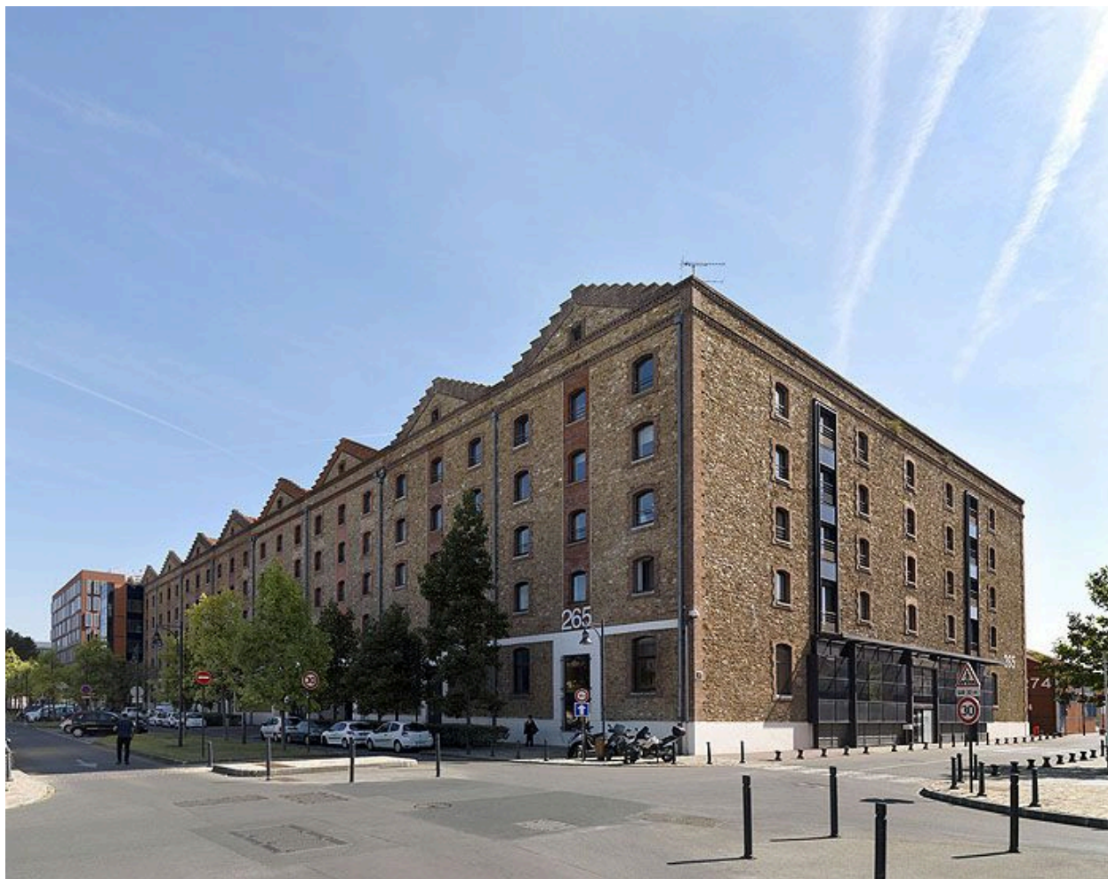
93, Saint-Denis, entrepôt commercial de la Compagnie des Entrepôts et Magasins généraux, 50 avenue Président-Wilson. Vue d'ensemble des entrepôts de meulière à nefs multiples et à pignons en pas-de-moineau (1903).
