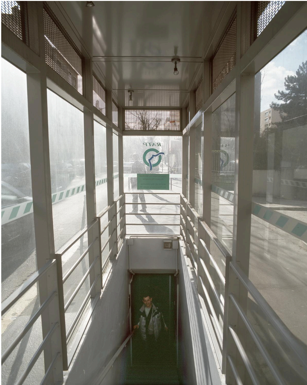
Edicule d'accès à l'atelier, face au 19, boulevard du Général-Leclerc-de-Hautecloque.
