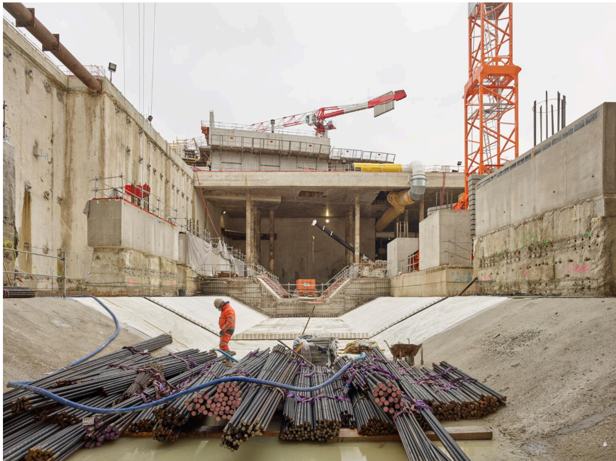
16/12/2020, chantier de construction de la station de métro Aéroport d'Orly (lignes 14 et 18).
