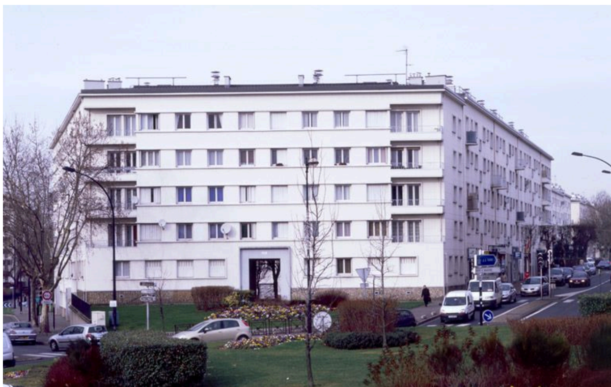
Cité Blanche, avenue de la République. Paul Pelletier et Michel Feuillas (architectes). Vue rapprochée depuis le rond-point du bas de l'avenue de la République.
