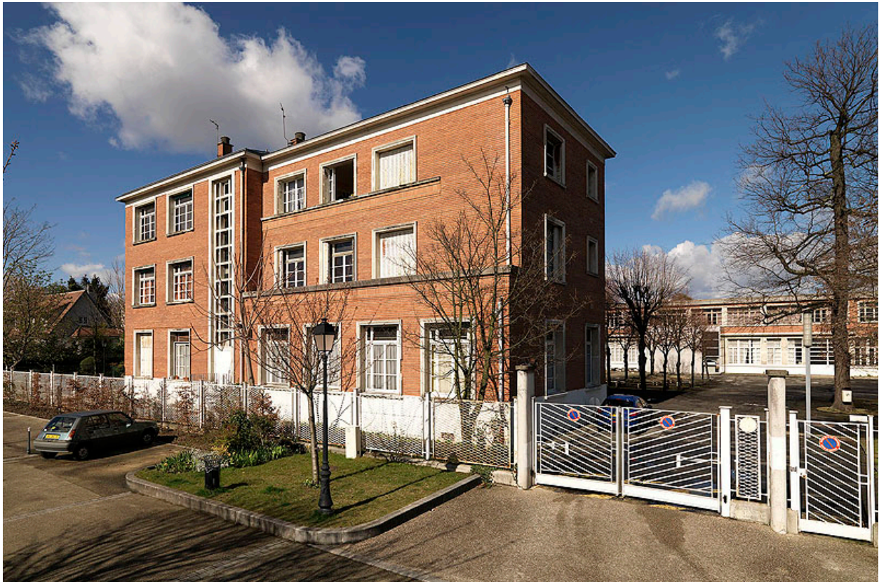
Vue de l'un des bâtiments du lycée professionnel.
