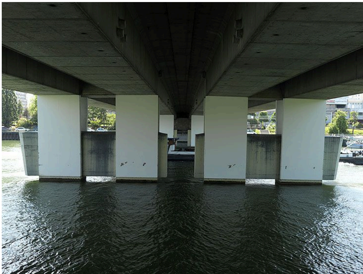
Choisy-le-Roi. Pont de Choisy (n°2). Détail d'une pile, vue dans l'axe du tablier.
