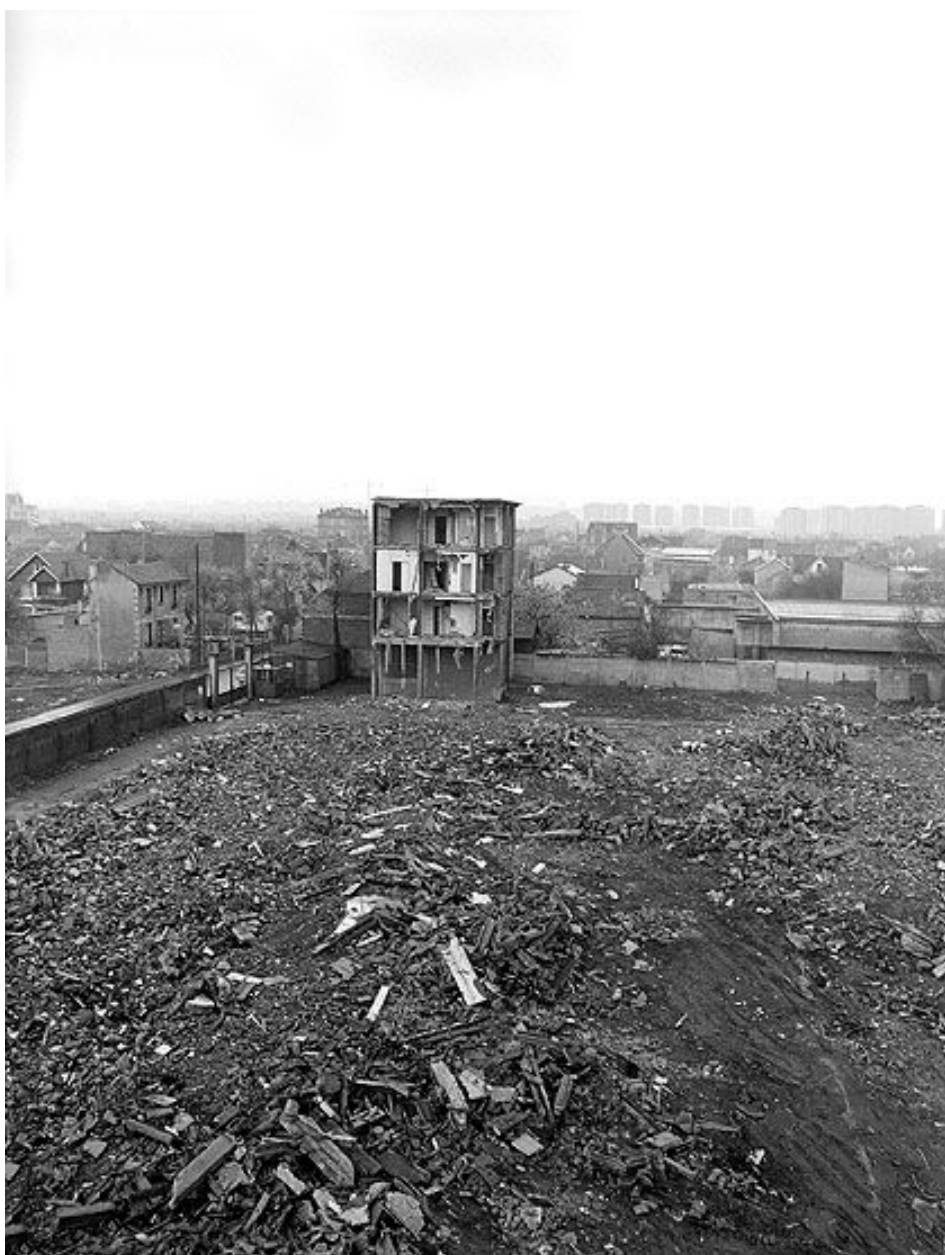
Peigne 10. Campagne photographique, lors de la destruction du bâtiment en 1976.
