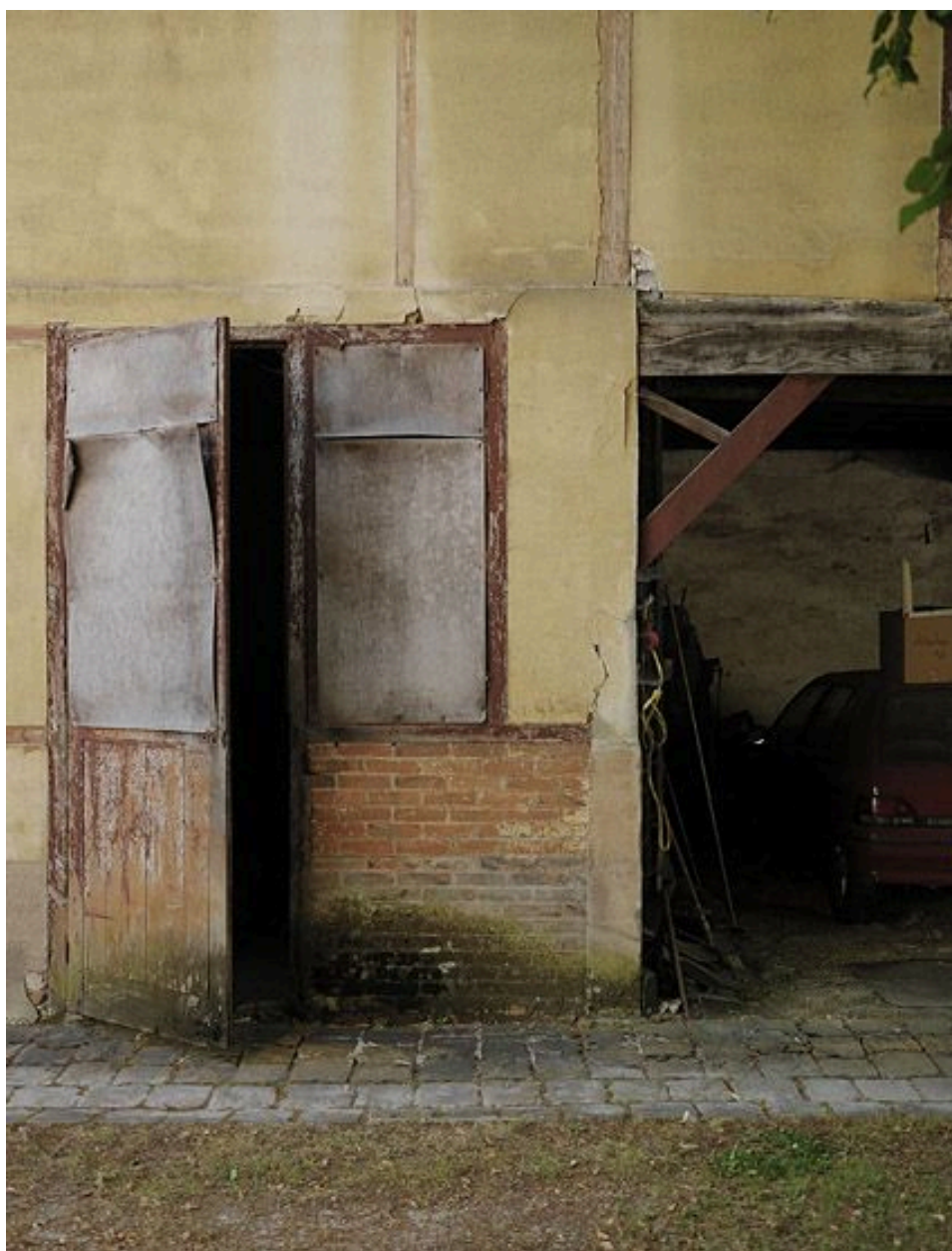
Atelier principal, partie réservée au logement des ouvriers, détail de maçonnerie.
