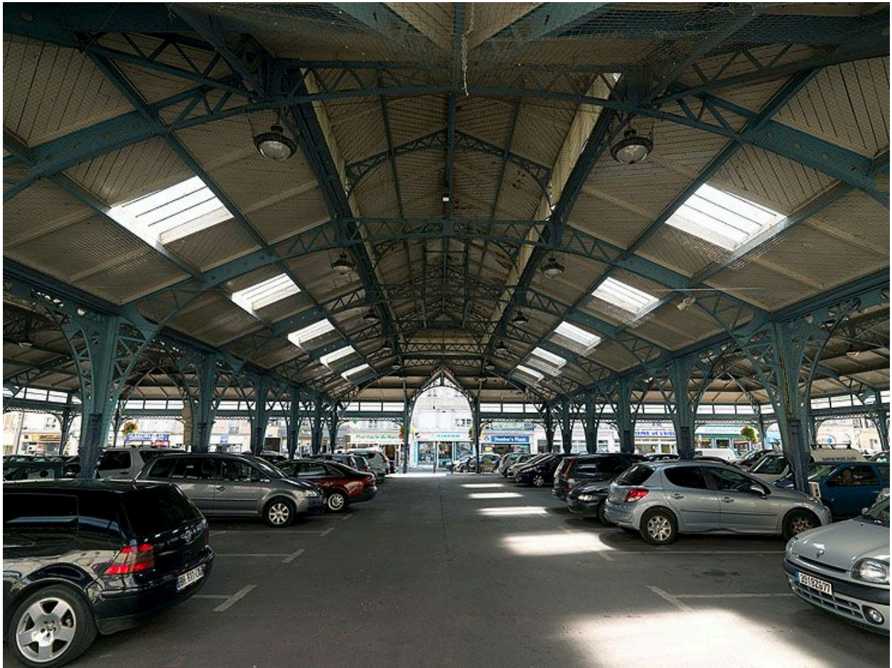
Vue intérieure du vaisseau central, de l'ouest vers l'est.
