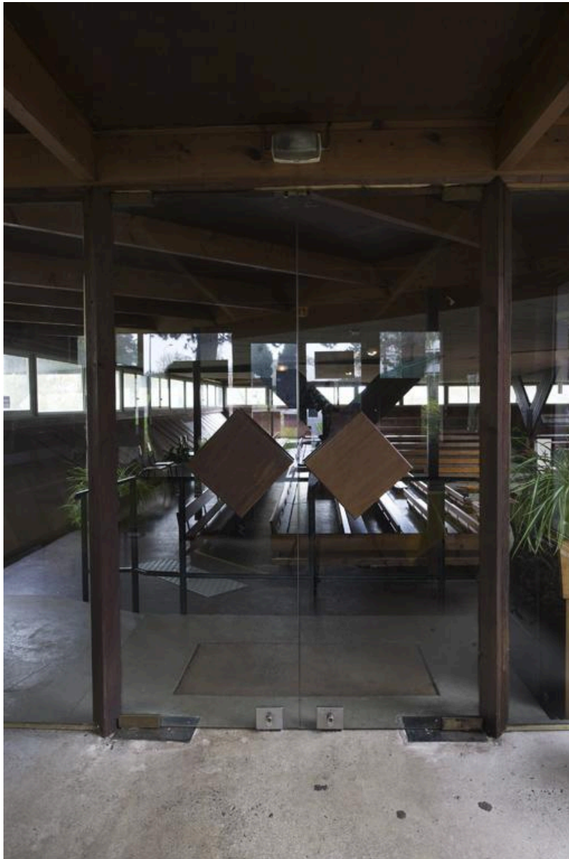
Porte d'entrée conservée (accès nord-est à la salle des assemblées).
