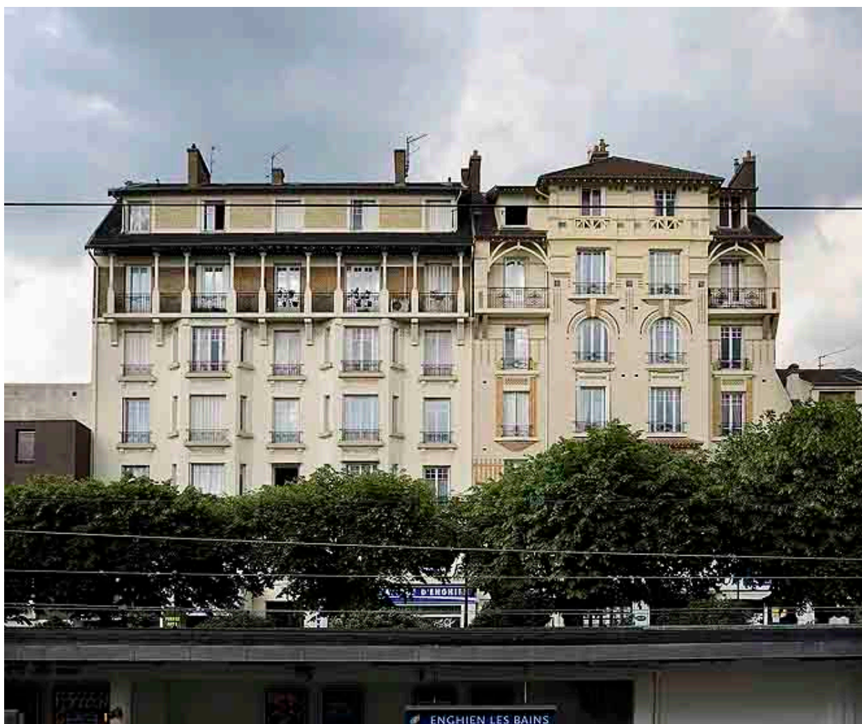
Vue d'ensemble de deux immeubles construits par l'architecte Henri Moreels, rue du Départ.
