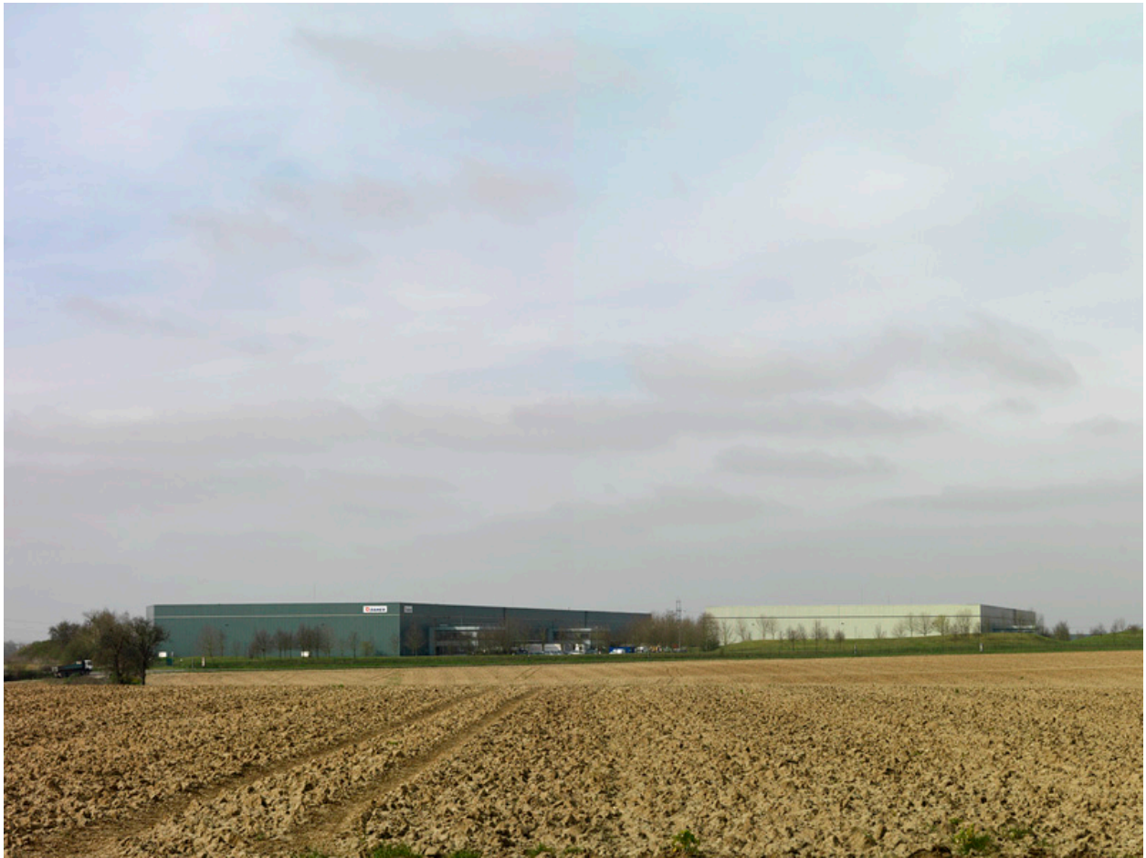
Saint-Witz, D16. L'activité fondue dans le paysage : entrepôt logistique de la ZAC Terres des Guepelles.
