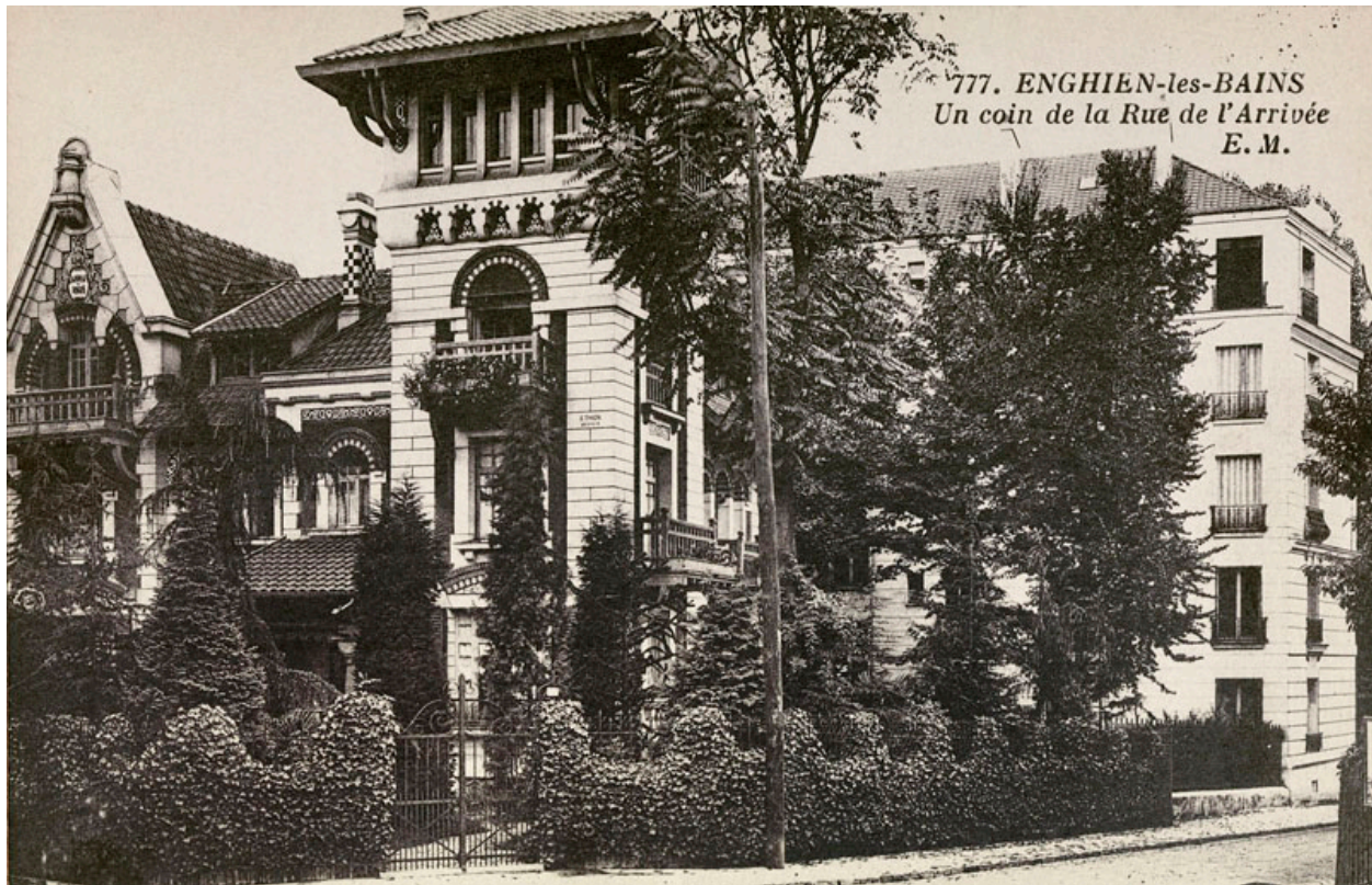
Vue d'ensemble de la maison avec l'immeuble construit ultérieurement et qui occulte la vue. Carte postale, 2e quart du 20e siècle. (AD Val d'Oise, 31Fi 59/1)
