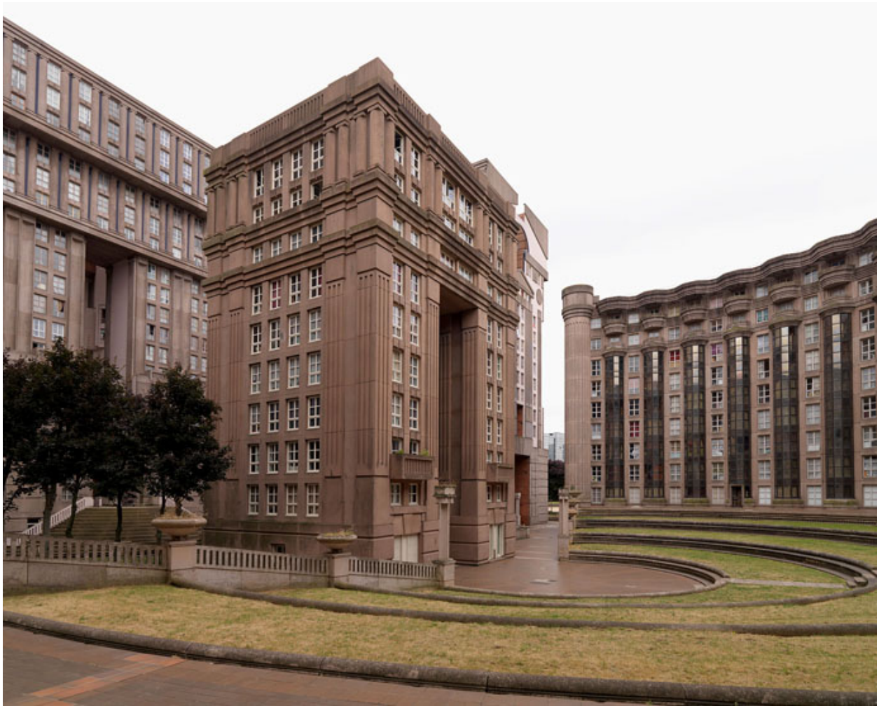
Espaces Abraxas, place des Fédérés, Ricardo Bofill, 1978-1983. Espace central du complexe.
