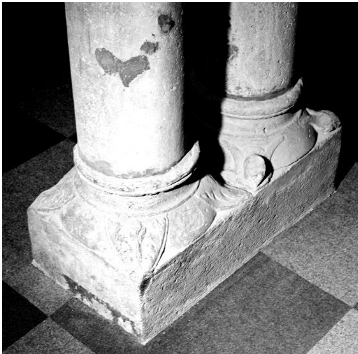
Arcade du cloître : base de la 4e paire de colonnes géminées.
