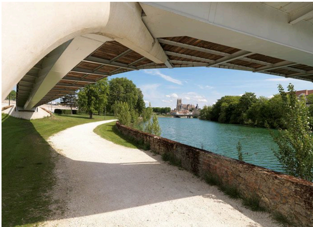
Partie inférieure de la passerelle, vue depuis le jardin des Trinitaires.
