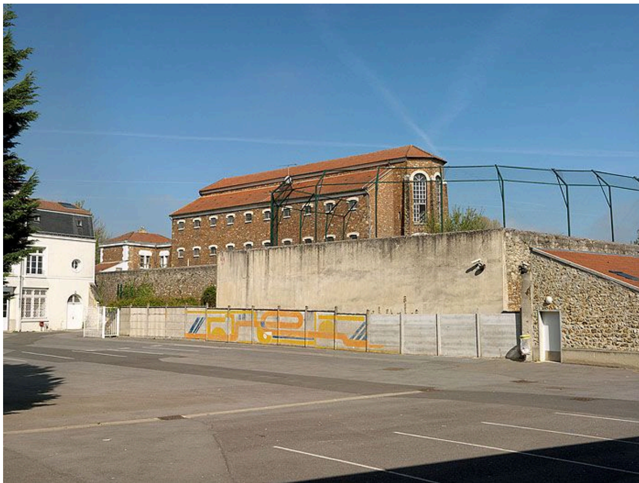
Elévations sud et est de la maison d'arrêt, vues depuis la cour du collège Henri IV.
