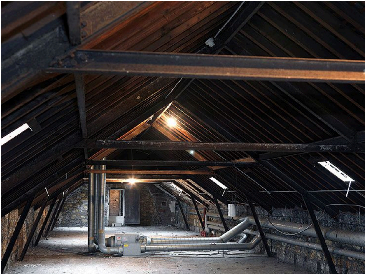
La charpente de l'un des bâtiments construits par Delaire.
