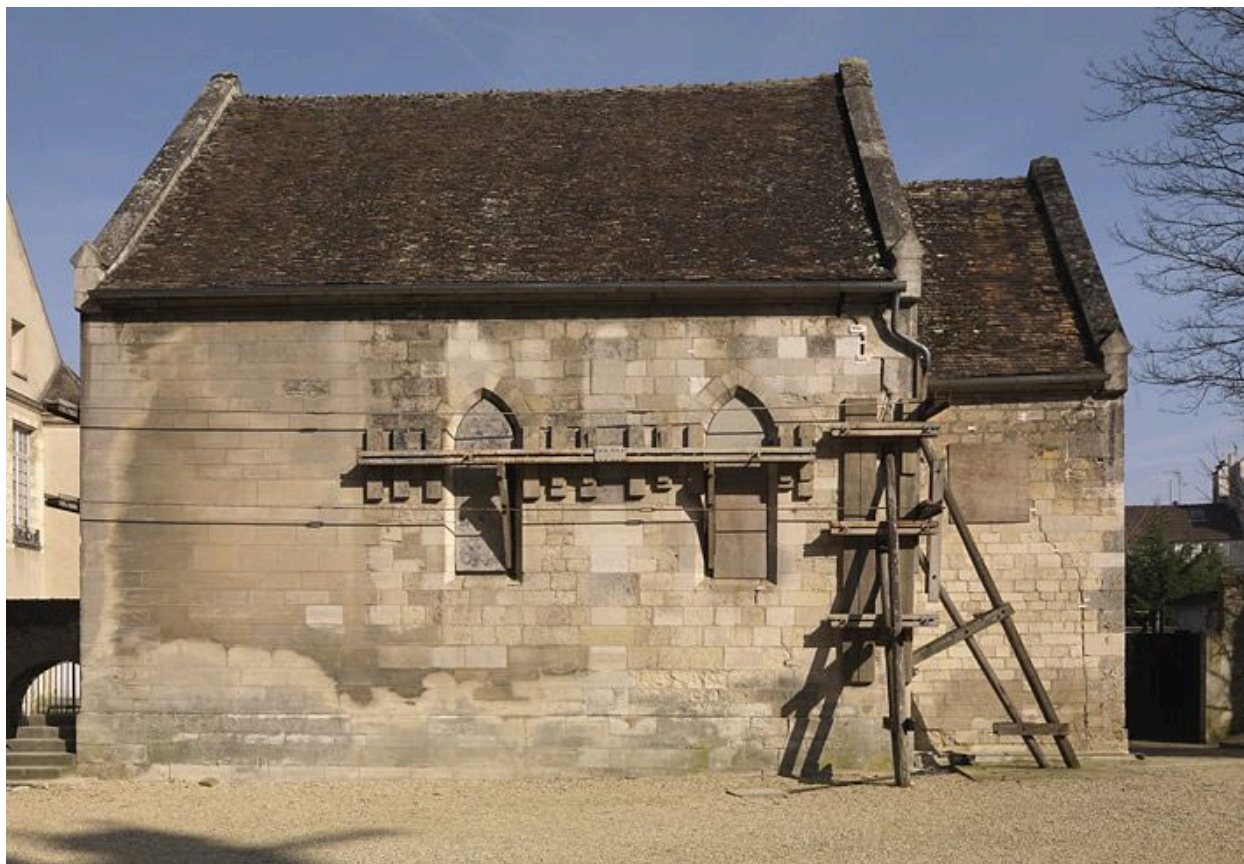
La "chapelle des catéchismes", vue du sud.
