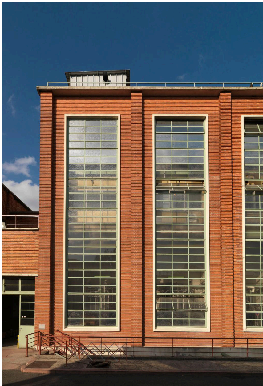
Site Sanofi. Vue du bâtiment renfermant les cuves de fermentation.
