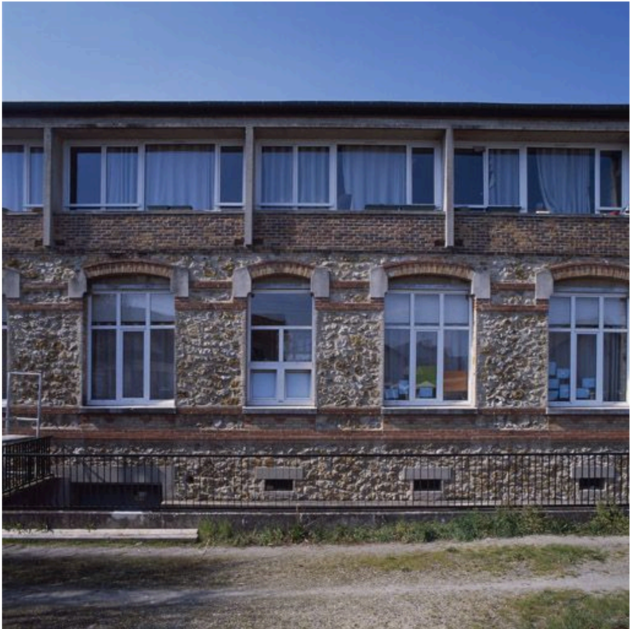
Vue partielle du corps central surélevé en 1960 par l'architecte Paul Chemetov.
