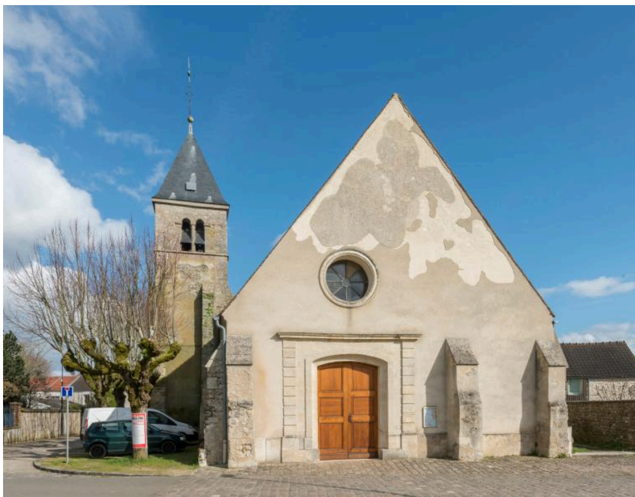
Vue extérieure, depuis l'ouest : la façade, et le clocher au second plan.
