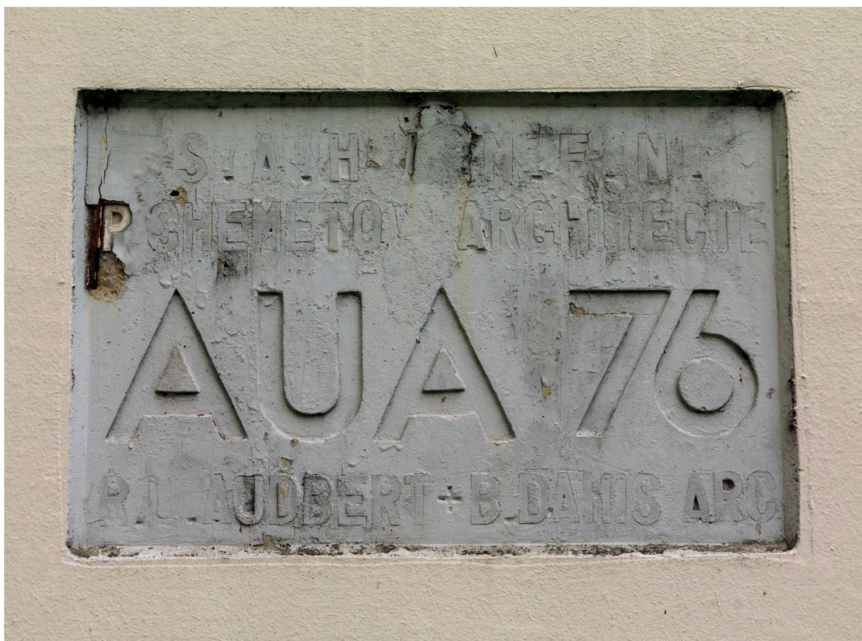
Cité dite Ilot 255. Plaque d'architecte : A.U.A 76, Chemetov Architecte.
