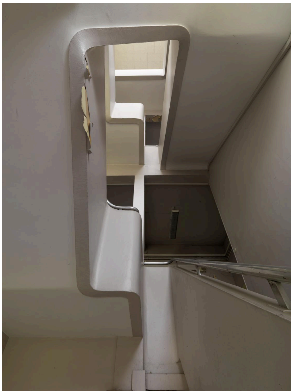
Site Sanofi. Escalier du bâtiment Nocard.
