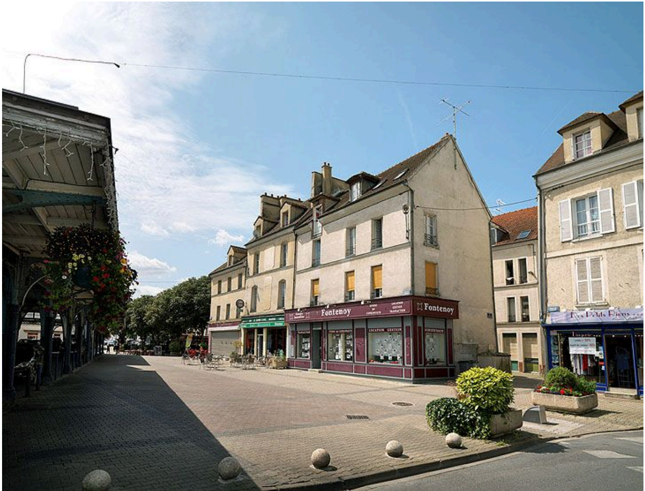
Vue de trois maisons anciennes formant un îlot, sur le côté ouest de la place du Marché. Au premier plan, la maison sélectionnée, 12 place du Marché.
